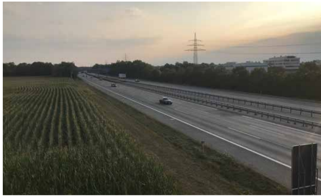
A99 mit Blick auf das Gewerbegebiet Ost
