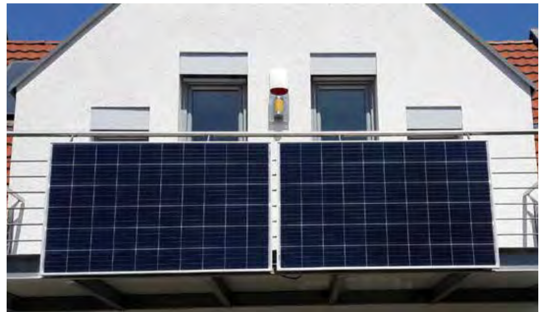
Solaranlage für den Balkon.
